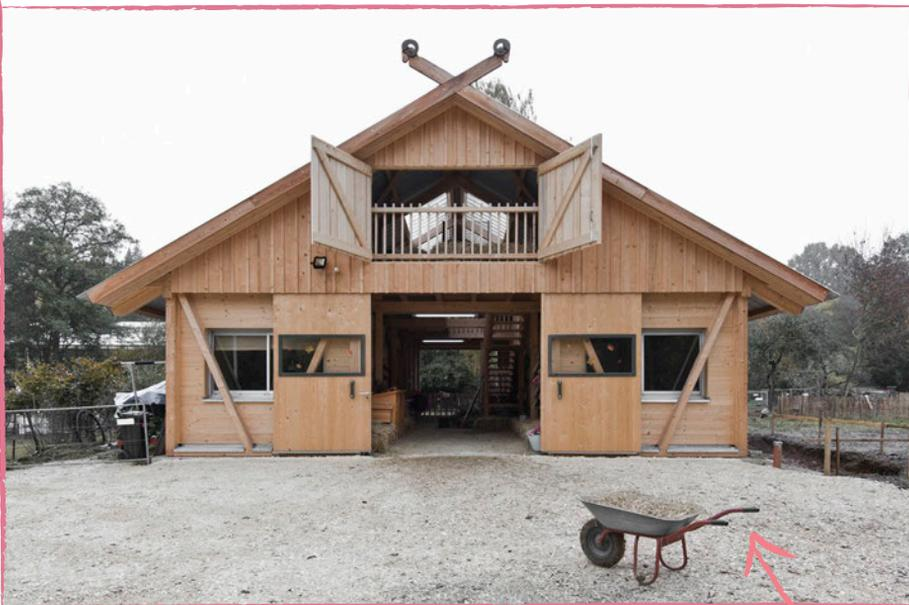
Der „Aufwindhof“ in Aalen: Aufgeständert als reiner Holzbau kommt der neue Kinderbauernhof nahezu ohne die Verwendung grauer Energien aus. Und ist bestechend einfach gebaut mit recycelten Materialien und gespendeten Bauteilen. Unter der Holzverkleidung stecken zwei Alt-Container | Kayser Architekten GmbH, Aalen mit Architektur + Werkstatt, Karl-Heinz Gsell, Aalen
