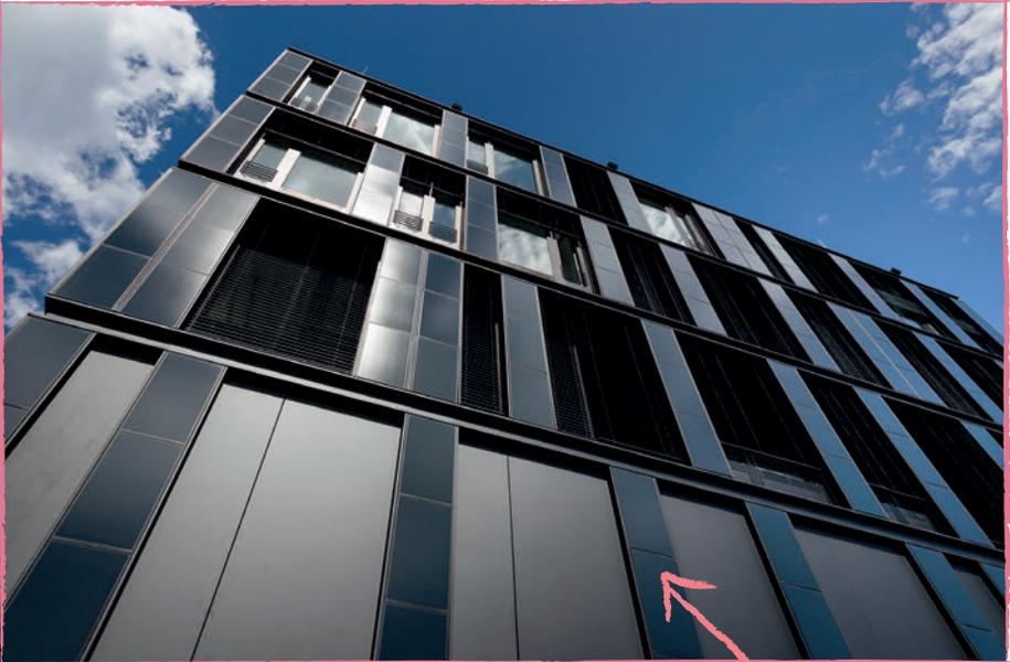
Eine Fassade, die Sonnenenergie in Strom umwandelt: das Zentrum für Sonnenenergie- und Wasserstoff-Forschung Baden-Württemberg in Stuttgart-Vaihingen hat sie schon, die bauwerksintegrierte Photovoltaik (BIPV) | Henning Larsen GmbH, München
