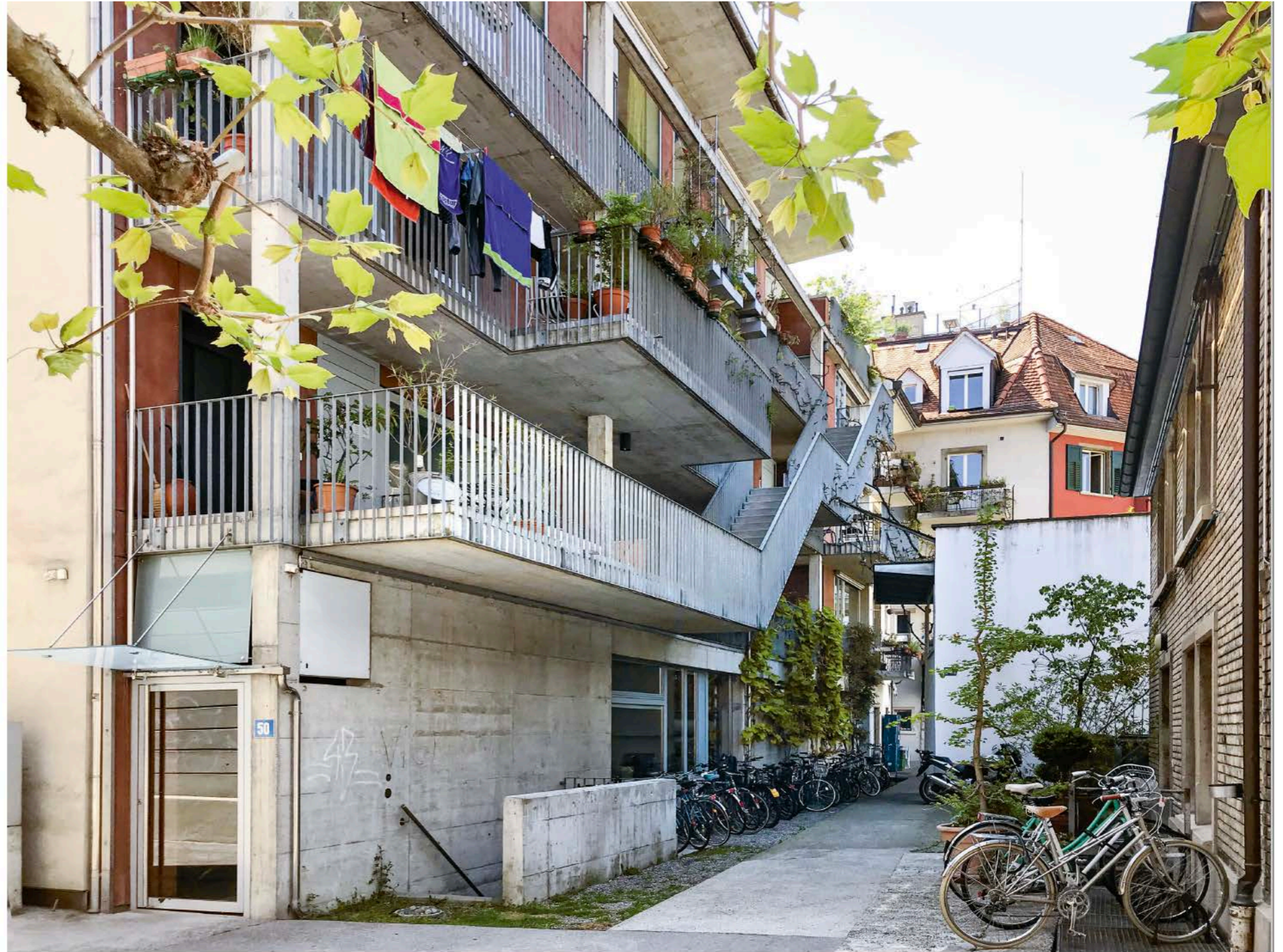
4 BLICK VOM HOF AUF DIE WOHNUNG
