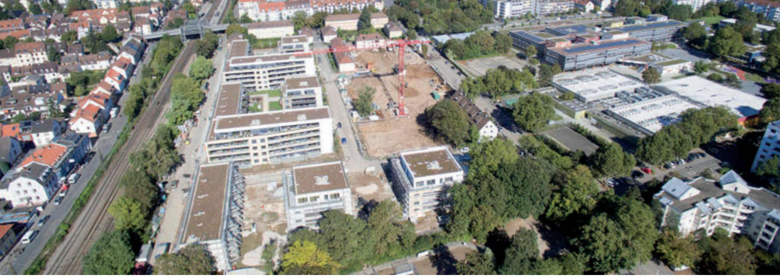
Stand der Bauarbeiten im Oktober 2016.
